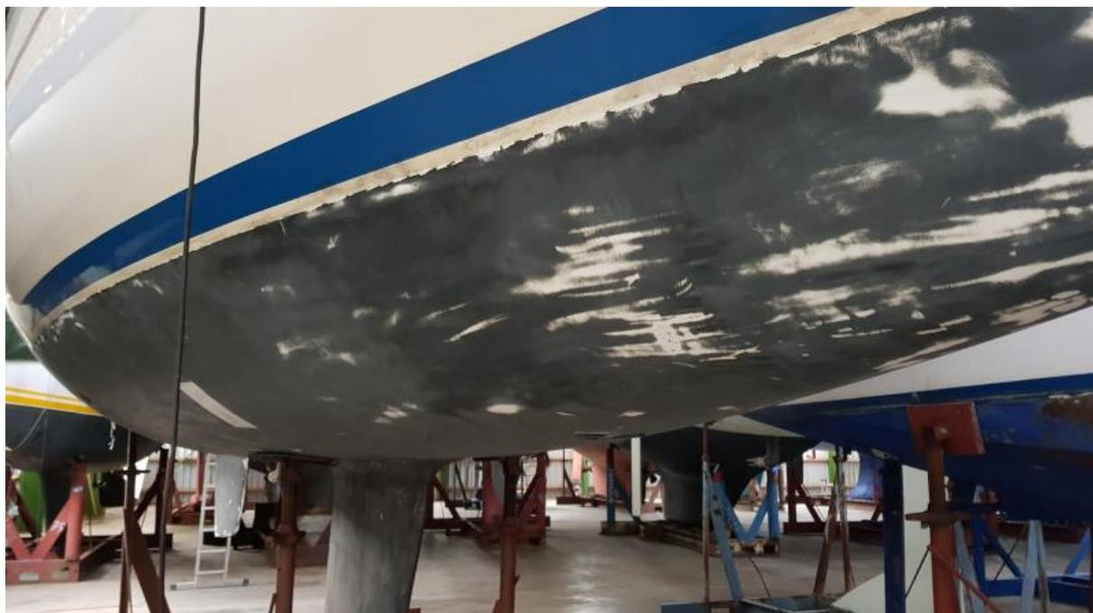
Auch auf der "Unterseite" der Yacht tut sich was. Das Unterwasserschiff ist komplett abgezogen, geschliffen und erhält einen neuen Aufbau. Klingt nach Grundsanierung, die nach 18 Jahren auch mal fällig ist. Das machen wir aber nicht selbst, damit habe ich meine Spezies beauftragt. Als wir oben fast fertig sind, fährt Karl vor und pönt den ersten Anstrich aufs Unterwasserschiff – es geht voran, am 1. April wird gekrant.
